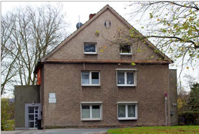
Haus des Typs 9 an der Straße „Lange Horst“ 2015
