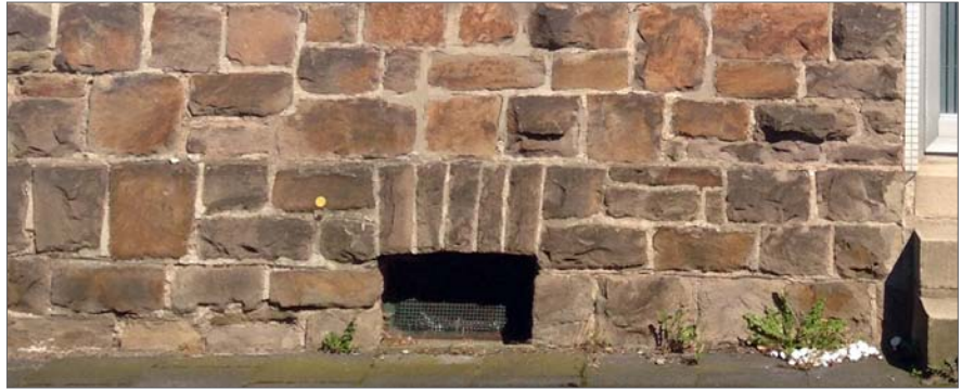
Detailaufnahme eines Bruchsteinsockels 2015
