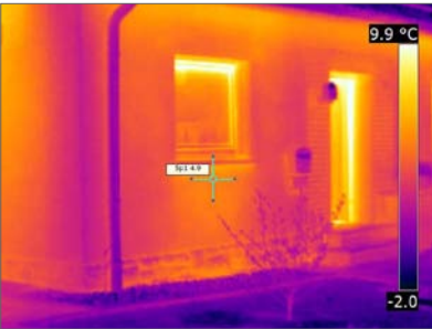
Heizkörper an der Außenwand
