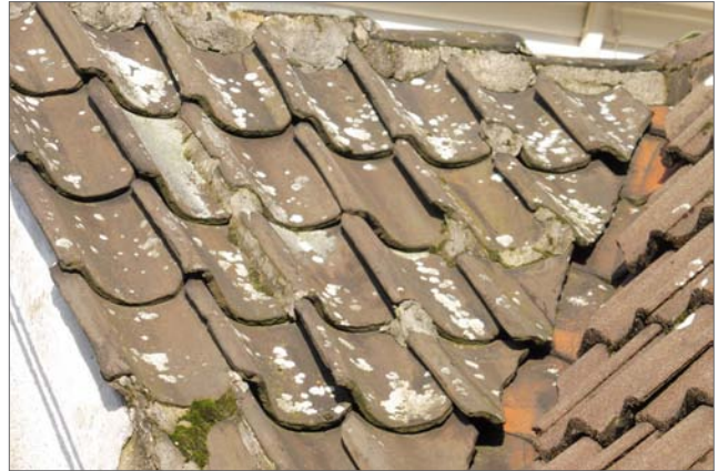
Detailaufnahme originale Dacheindeckung 2016 (Stadt Hattingen)
