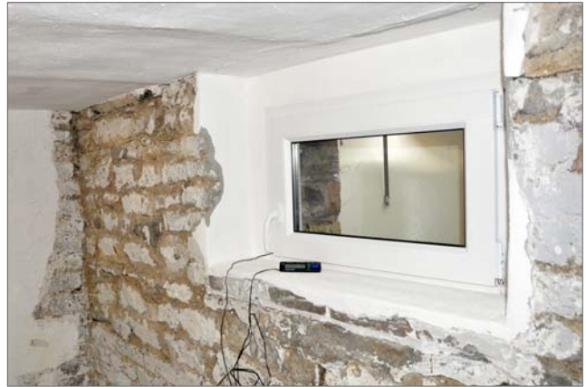
Kellermauerwerk eines Hauses an der Rathenaustraße, Putzschicht entfernt 2015
