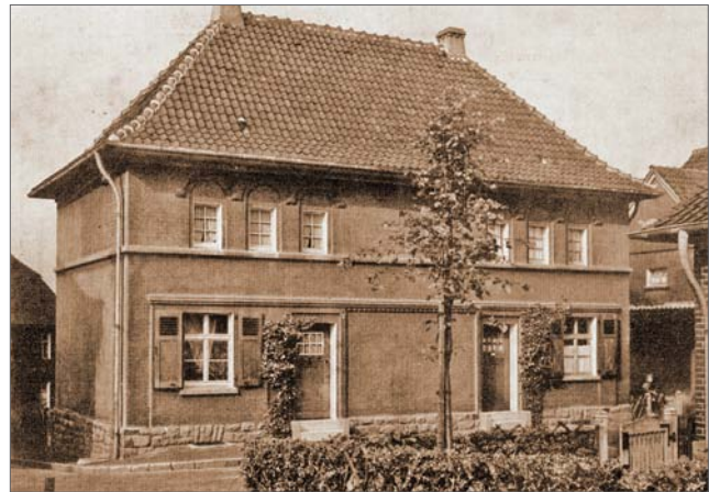
Fassadenaufbau eines Hauses des Typs 1 1920er Jahre (aus: Georg Metzendorf: Kleinwohnungsbauten und Siedlungen. Darmstadt 1920, S. 115 / 116)
