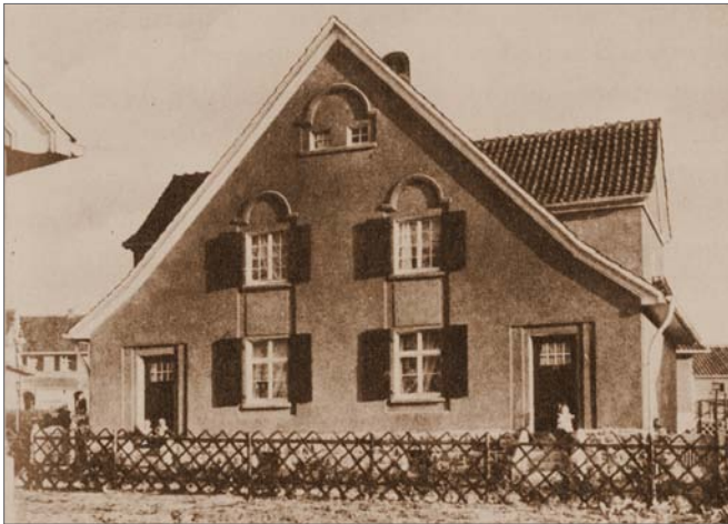
Haus des Typs 2 1920er Jahre (aus: Rainer Metzendorf: Georg Metzendorf. 1874-1934. Siedlungen und Bauten. Darmstadt 1994, S. 143, Abb. 141)
