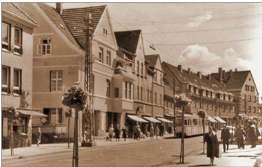
Geschäftshäuser an der Marxstraße, Blick von Westen 1950er Jahre (Stadt Hattingen)
