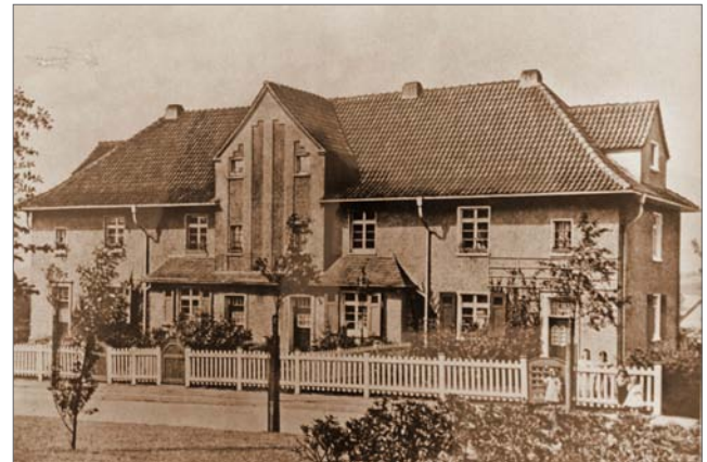
Viererhaus (Gartenstraße) um 1920 (Gartenstadt Hüttenau eG)
