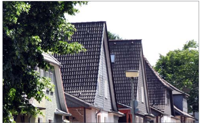
Blick in die Gartenstraße 2015
