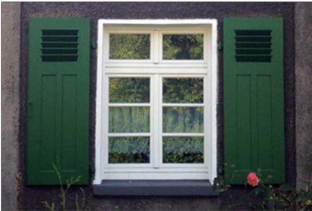
Detailaufnahme eines „klassischen“ Fensters 2015
