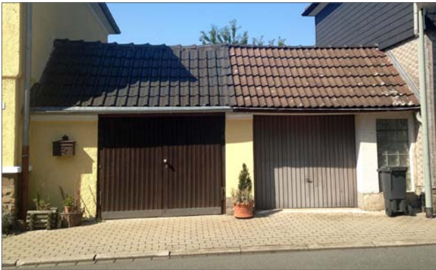
In historische Zwischenbauten eingefügte Garagen 2015
